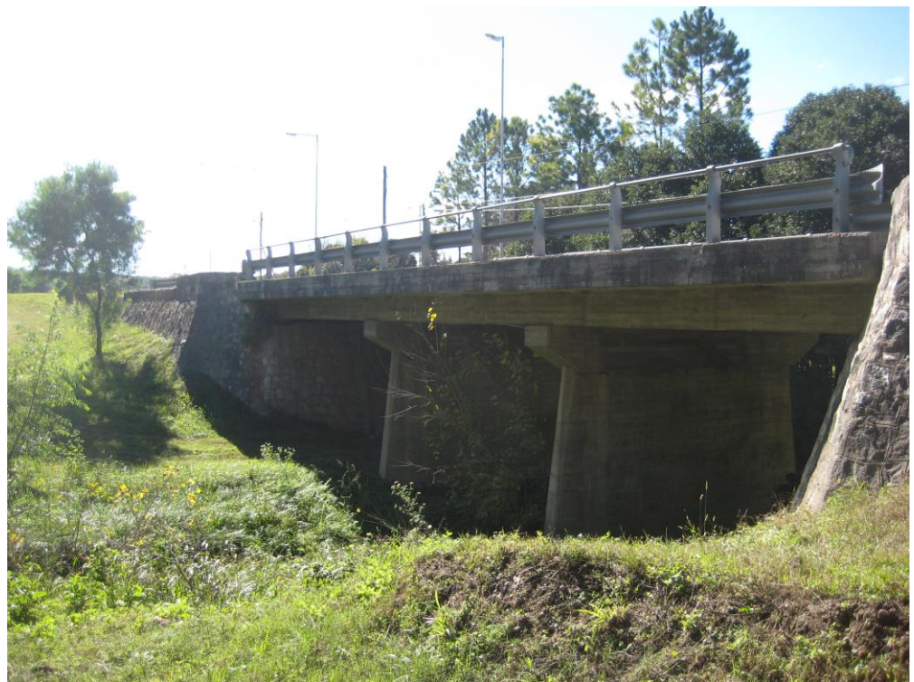
Ilustración 1. Puente existente sobre A° Falda del Carmen
